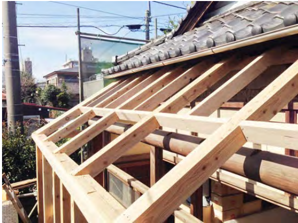
耐震補強工事
